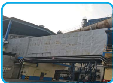
回转窑系统安装隔音墙
