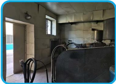
风机房采用吸音材料降低噪音
