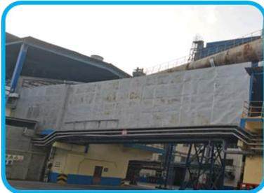
回转窑系统安装隔音墙
